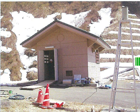
地震で左後方に30cm沈下
