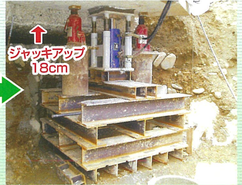
ジャッキアップの様子
