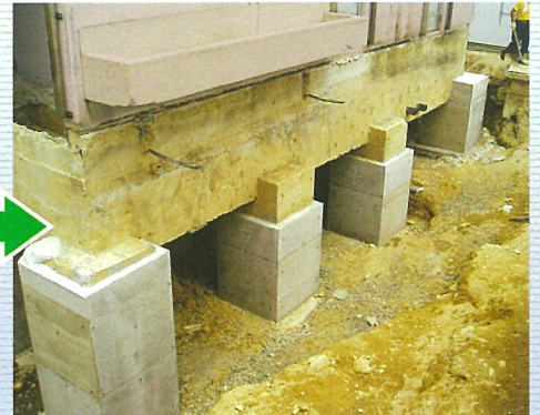
フーチング、杭を補強 コンクリート
