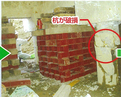
地中梁にジャッキセット、仮受工事
