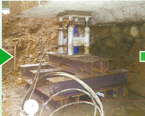
基礎下掘削、鋼材、ジャッキセット
