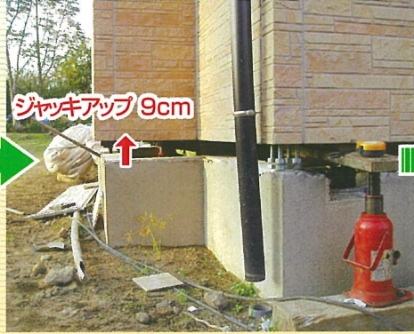
ジャッキアップ工
