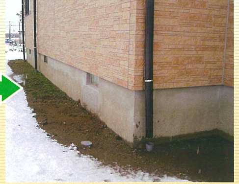
基礎補強、完了
