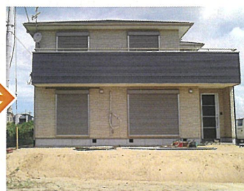
新設基礎に定着
