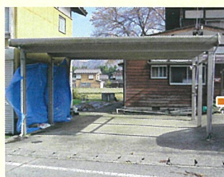
沈下したカーポートのジャッキアップ工事
